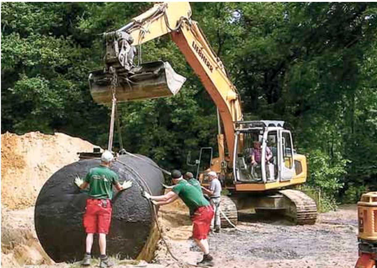
Der riesige Löschwassertank mit 30.000 Litern wurde im Frühjahr komplett versenkt. Inzwischen sieht man nur noch einen Hydranten. Es dauerte Stunden, den Tank anschließend zu befüllen.
