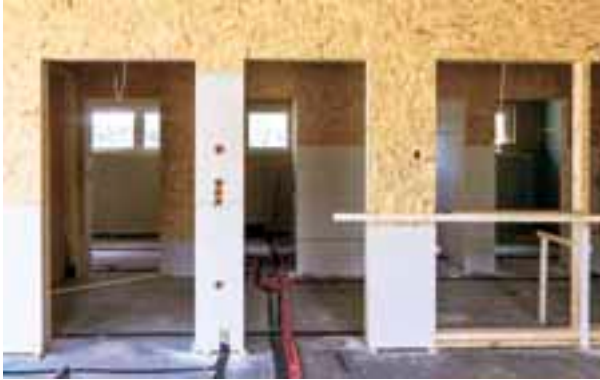
Schon im Frühjahr konnte der Innenausbau starten.
